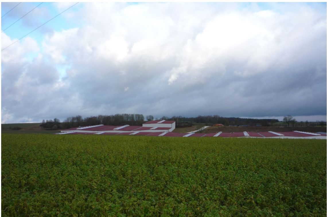
Abb. 5: Einbindung der Planung in die Landschaft – Darstellung der Betriebserweiterung Blickrichtung von Süden
